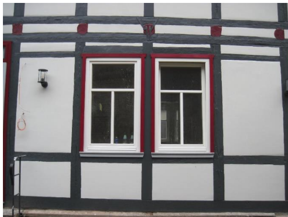
Fenster mit T-Teilung in einer Fachwerkwand
