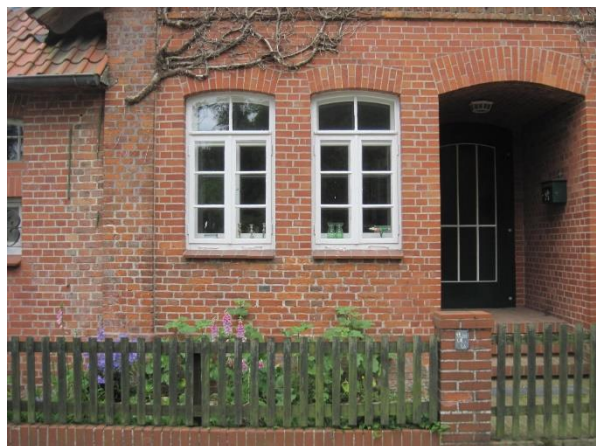
Erneuerte Fenster in einer Ziegelfassade
