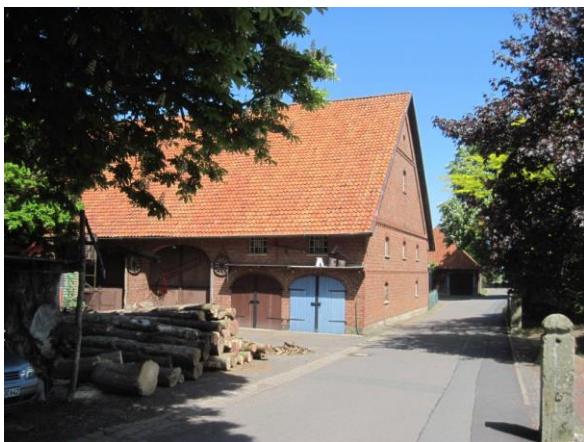
Naturrote Ziegeleindeckung eines Wirtschaftsgebäudes
