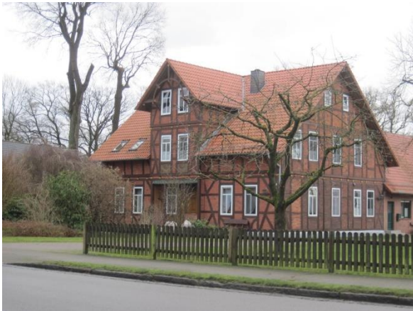
Fassade in Fachwerk mit Ausmauerung
