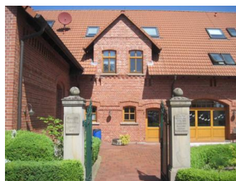
Zwerchhaus und einige Dachflächenfenster zur Belichtung des Dachgeschosses
