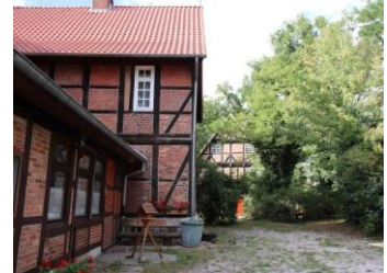
Haupt- und Nebengebäude in Fachwerk
