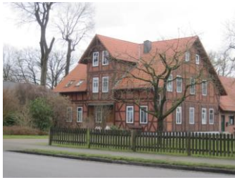
Fassade in Fachwerk mit Ausmauerung
