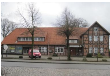
Langgestreckter, lagerhafter Baukörper
