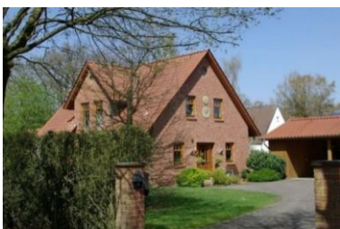
Passender Neubau im dörflichen Kontext
