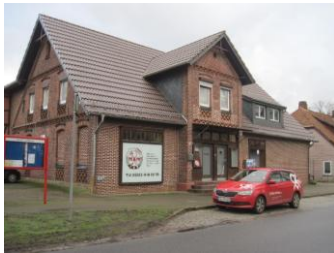
Fassade aus rotem Ziegel mit Zierwerk
