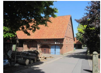
Naturrote Ziegeleindeckung eines Wirtschaftsgebäudes
