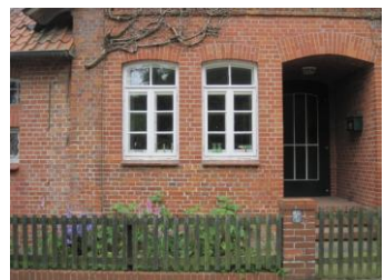
Erneuerte Fenster in einer Ziegelfassade
